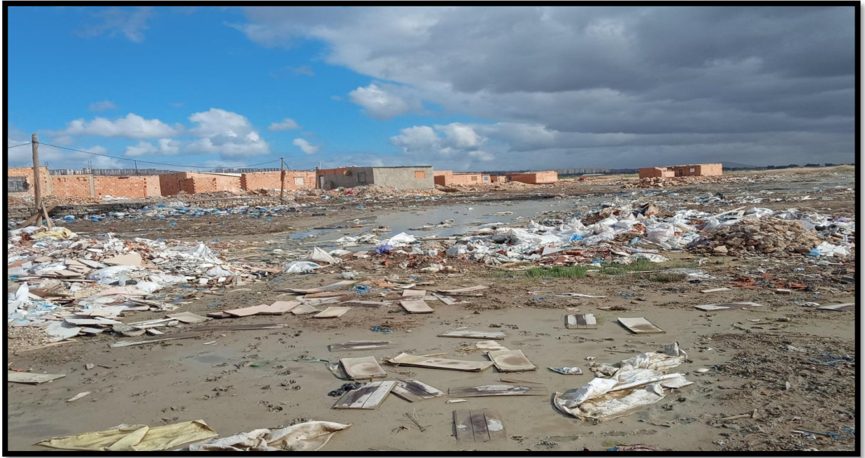
الصورة رقم (10-11) ردم السبخة لكيلا يطفو ماؤها على السطح
