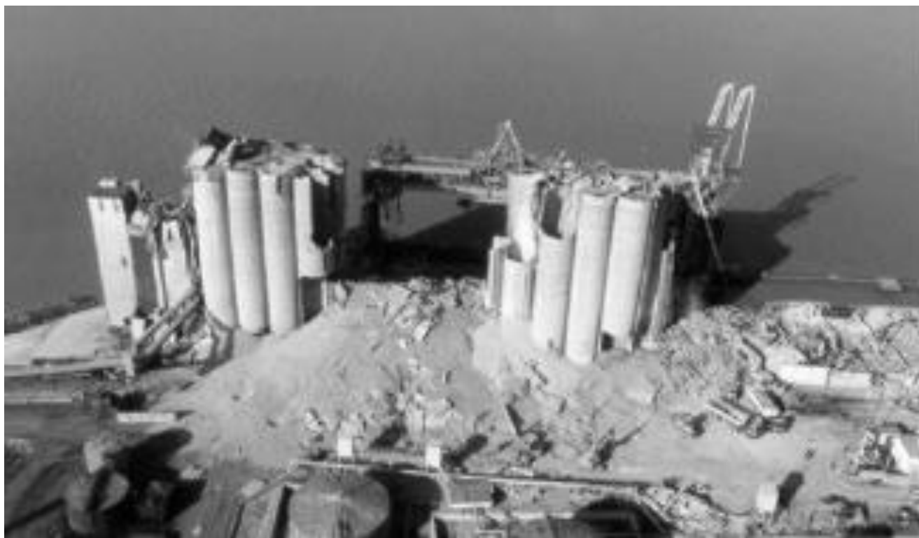
Figure VI : Vue du silo vertical après l'explosion
