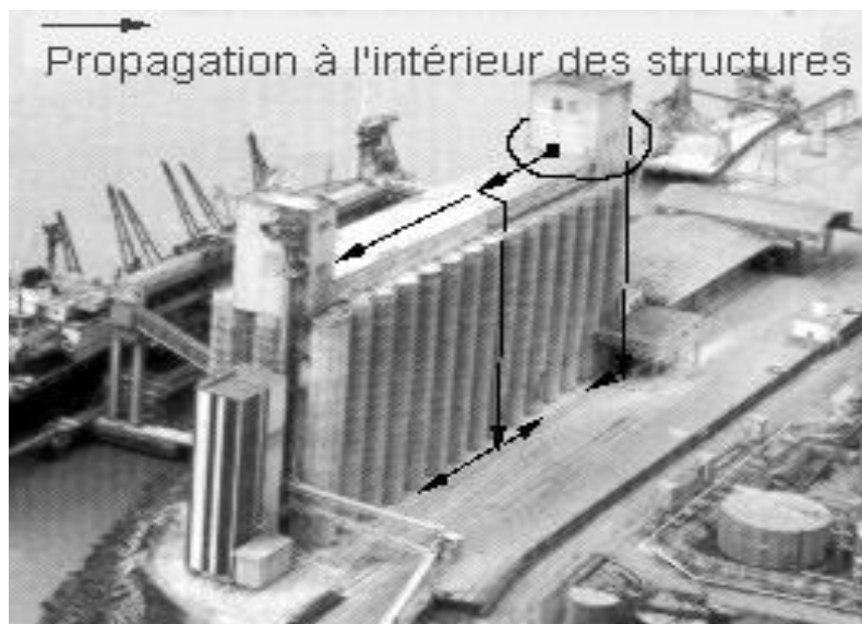
Figure VI. 6 : Parcours supposé de l'explosion
