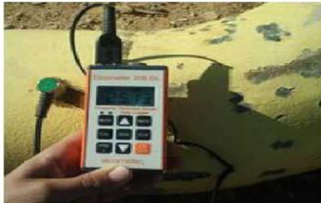
Figure 26 : la mesure d'épaisseur par l'appareil ultrason
