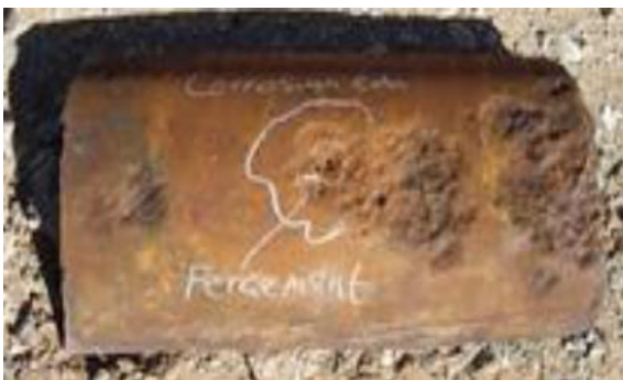
Figure 22 : Percement d'une conduite enterrée (vue externe)
