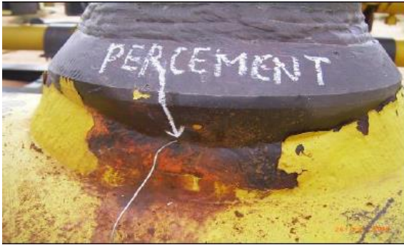
Figure 21 : Percement du cordon soudure du té de gare
