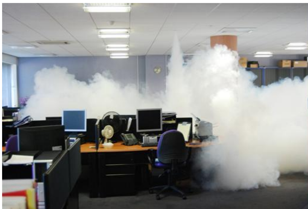
Figure III- 2 : Exemple d'extinction avec CO2
