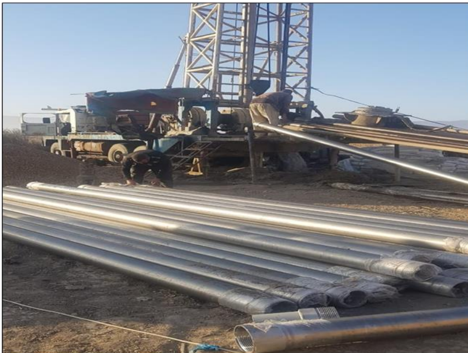
Figure 24 : Tube pleins en Inox en Ø8'' 5/8 (sur chantier)
