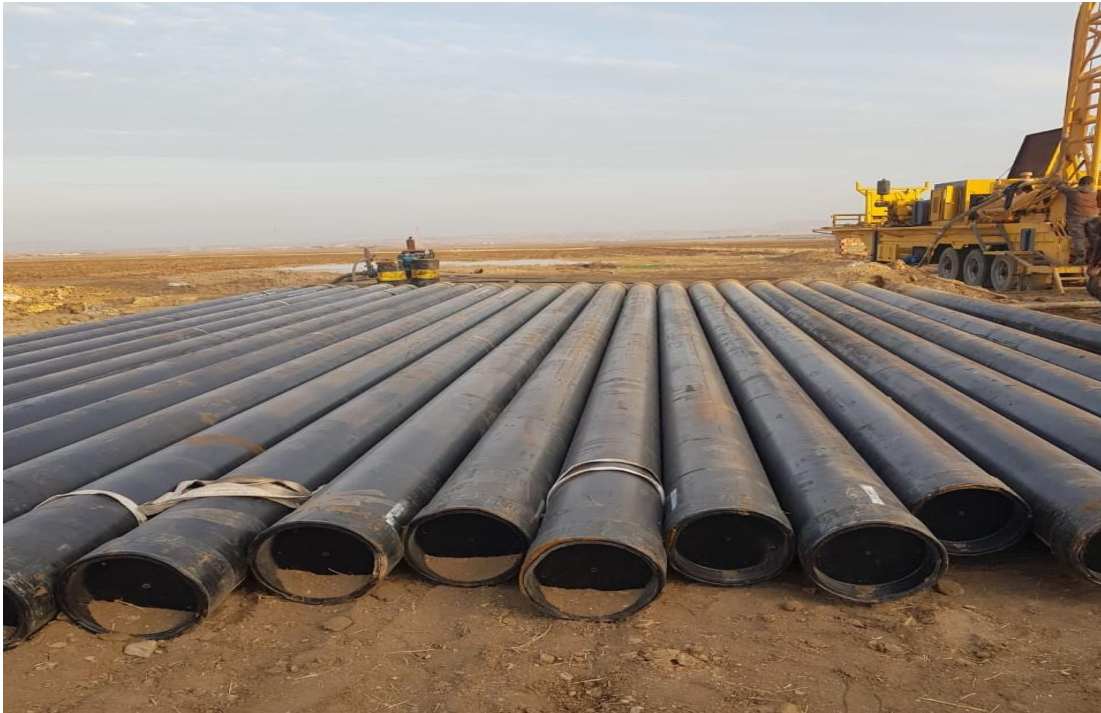
Figure 22 : Tube plein API Ø13 3/8 (sur chantier)
