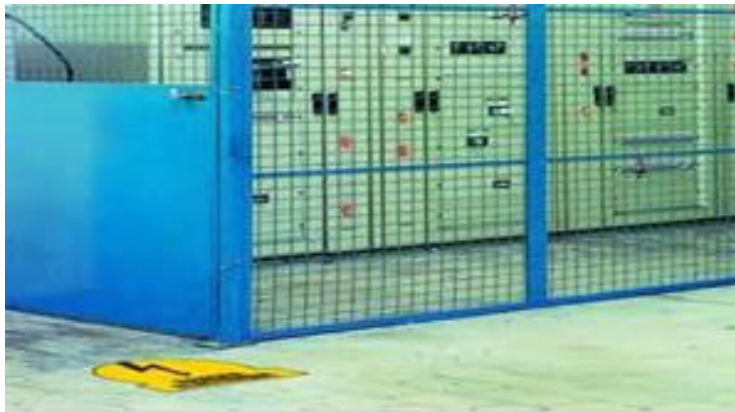
Figure V.13: Protection par grillage
