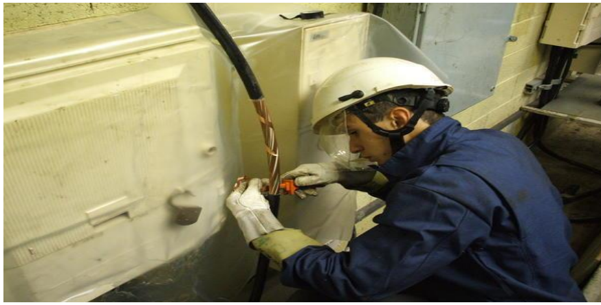
Figure II.31: Travail sous tension dans un sous-sol
