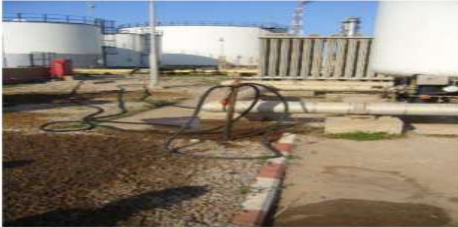
Figure IV.4 : Zone de distribution de carburant (fuel).
