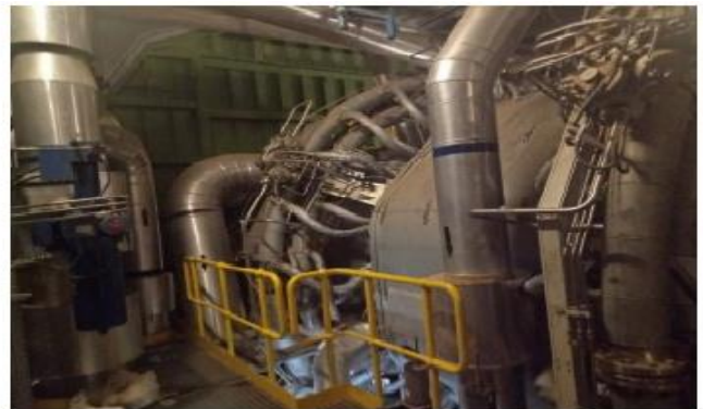
Figure 3.6 : Turbine à gaz GT 26
