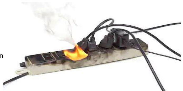
Figure 1.7 : Incendie d'origine électrique
