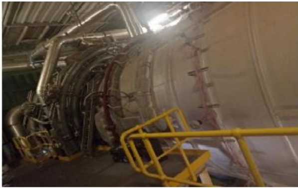
Figure 3.6 : Turbine à gaz GT 26
