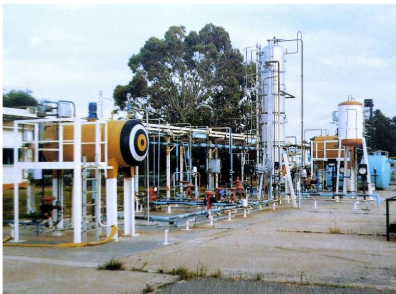
Figure 8: vue de l'ancienne UPCA
