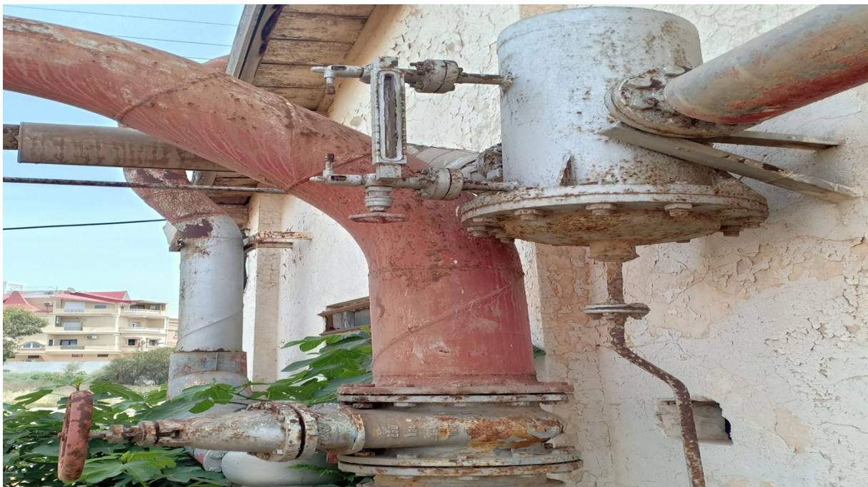
Figure 12: vue du sécheur séparateur.
