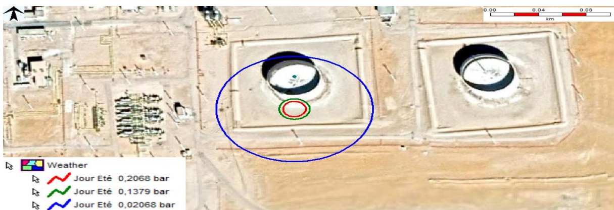
Figure 44 : Les effets de l'explosion (moyenne fuite)
