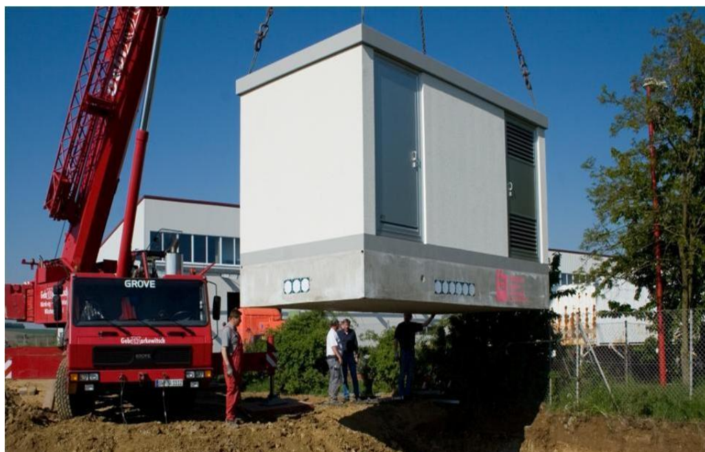
Figure 14 : Installation d'un local technique
