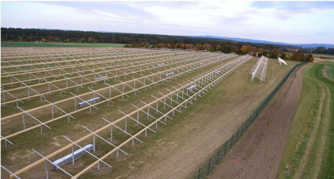
Figure 11 : Montage des structures porteuses
