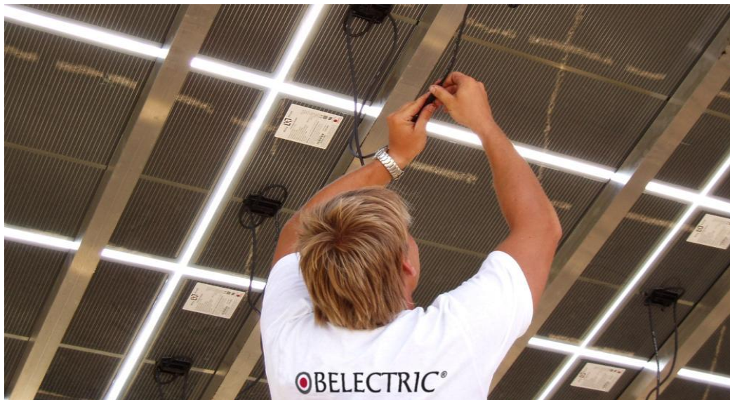
Figure 13 : Raccordement des modules
