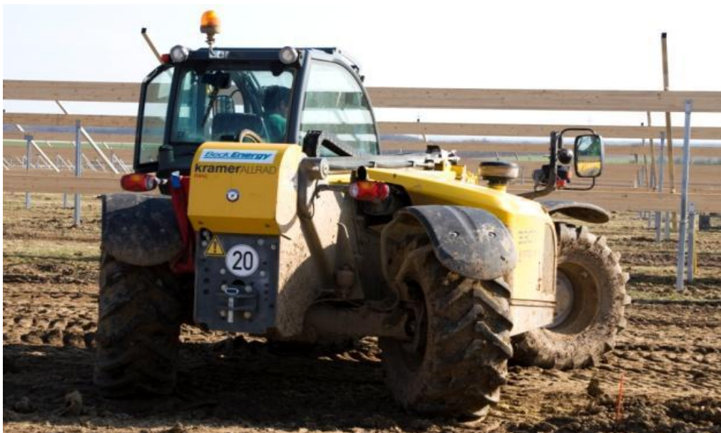
Figure 9 : Types d'engins nécessaires sur le chantier
