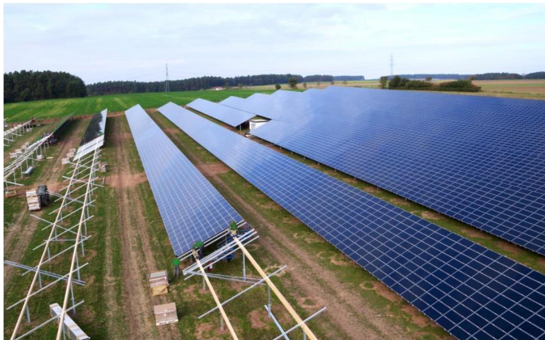
Figure 12 : Montage et installation des modules sur la structure porteuse
