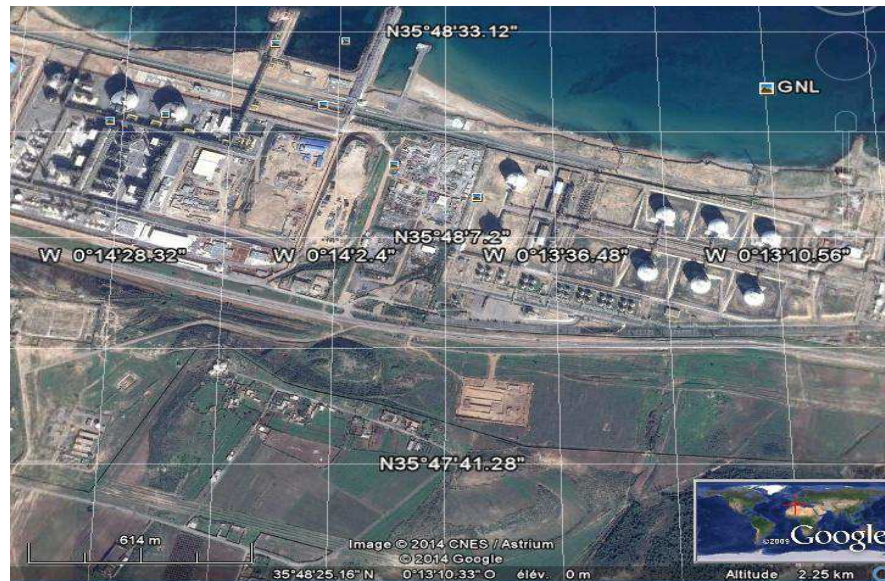
Fig. 33- Situation géographique du complexe GL1/Z [2].
