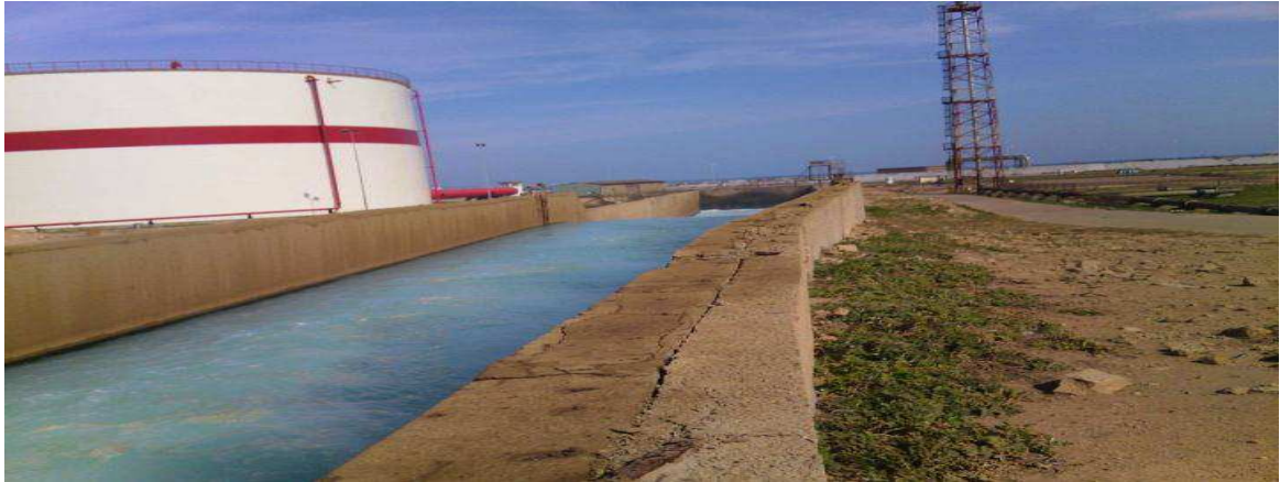
Fig. 29 – Canal du rejet du complexe GL1/Z.
