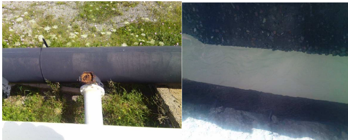
Fig. 38 - Point de prélèvement à l'entrée et à la sortie de la station CPS.
