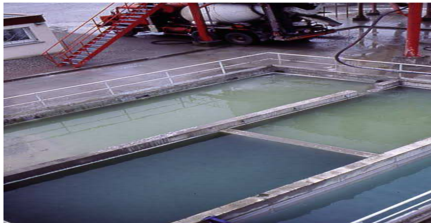
Fig. 31 - Centrale de fabrication du béton.
