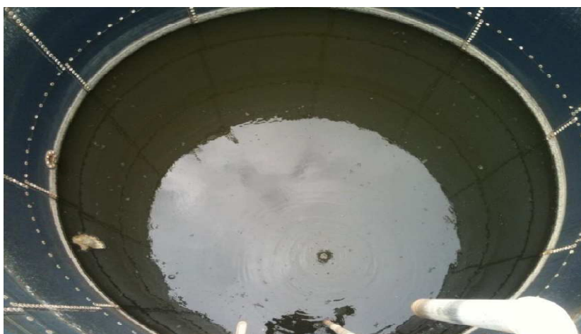
Fig. 35 - Point de prélèvement P1 (Amont de la station).
