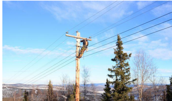
Figure I.8 : Les lignes à haute tension véhiculent l'électricité
