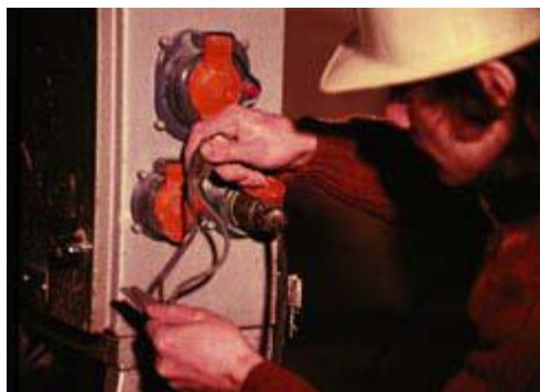
Figure IV.7 : Intervention de dépannage en basse tension
