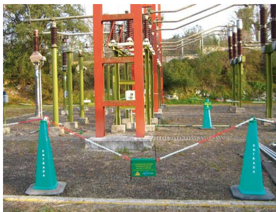
Figure III.7. Zone de travail signalisée
