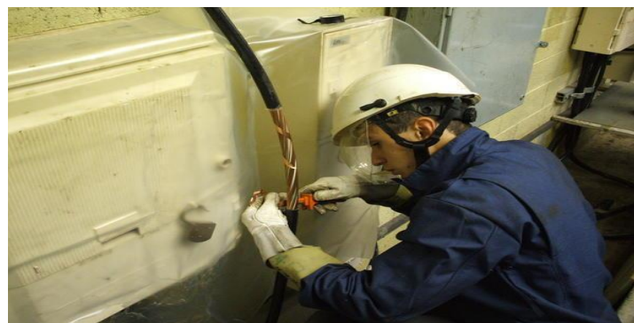
Figure II.2: Travail sous tension dans un sous-sol
