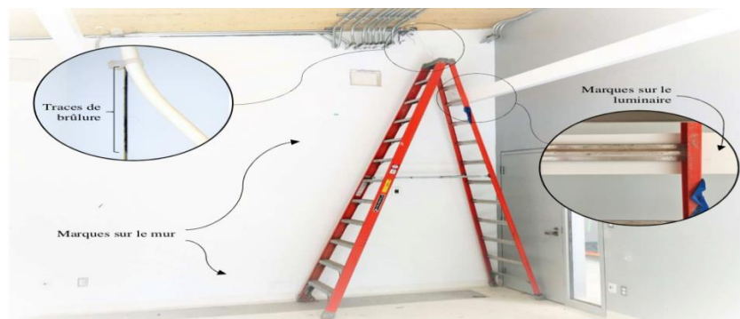
Figure I.10 : Position de l'escabeau au moment de l'accident
