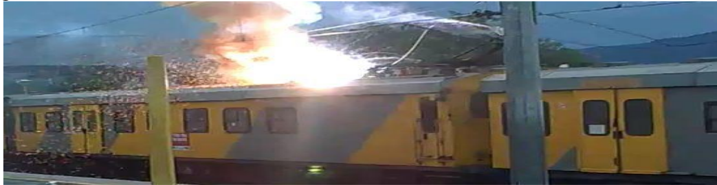
Figure II.27 : Explosion d'origine électrique
