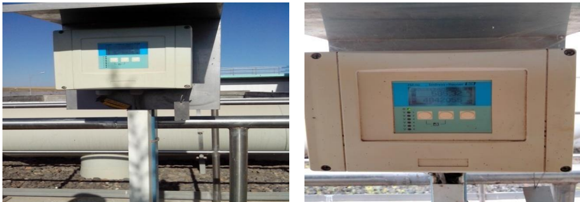
Figure III.9: Débitmètre à ultrason (Keddar et Mankouri, 2021).
