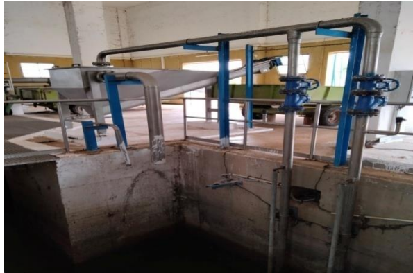
Figure III.6 : piège à sable (Keddar et Mankouri, 2021).
