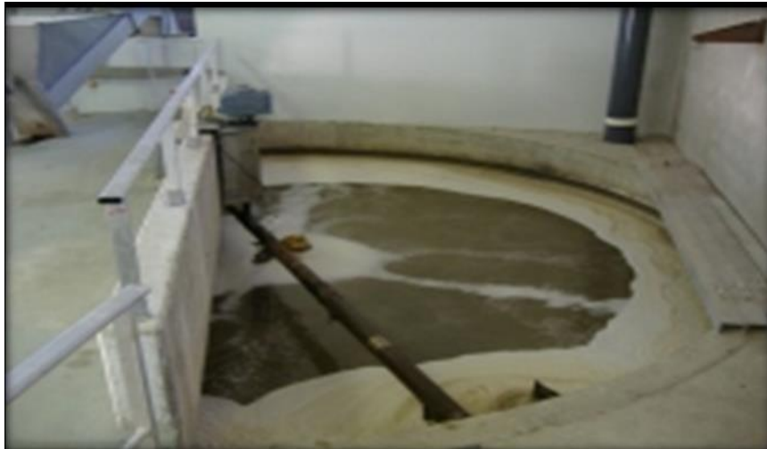
Figure II.3: Photo d'un dégraisseur-déshuileur ( Web 2 ).
