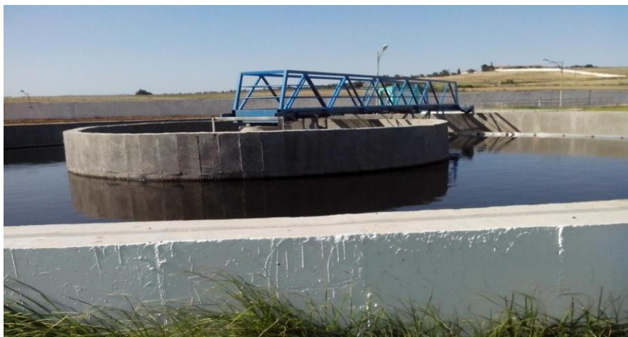
Figure III.14: clarifloculateur (Keddar et Mankouri, 2021).
