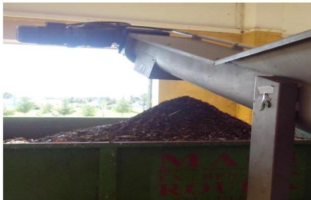
Figure III.7 : évacuation des sables (Keddar et Mankouri ,2021).
