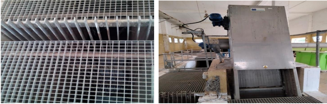
Figure III.4 : Grille verticale manuelle (Keddar et Mankouri, 2021).
