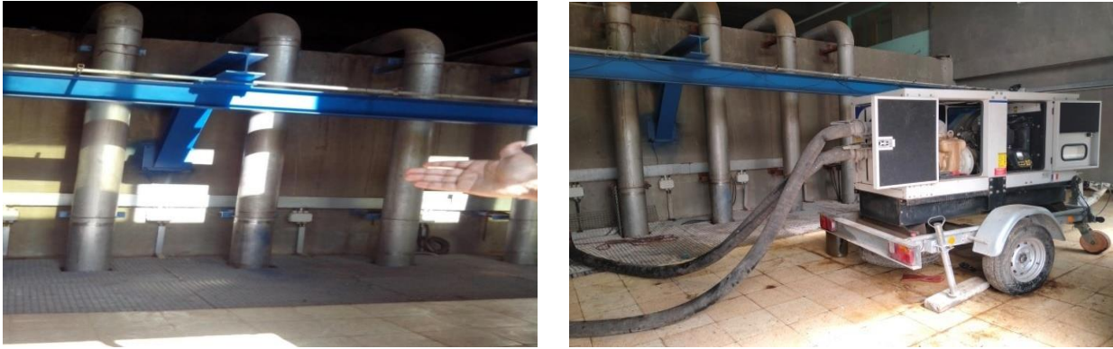
Figure III.10: Poste de relevage (Keddar et Mankouri, 2021).
