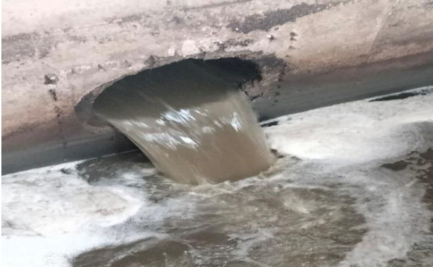
Figure III.3 : Déversoir d'orage (Keddar et Mankouri, 2021).
