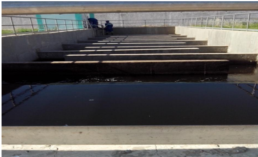
Figure III.15 : Bassin de désinfection (Keddar et Mankouri, 2021)
