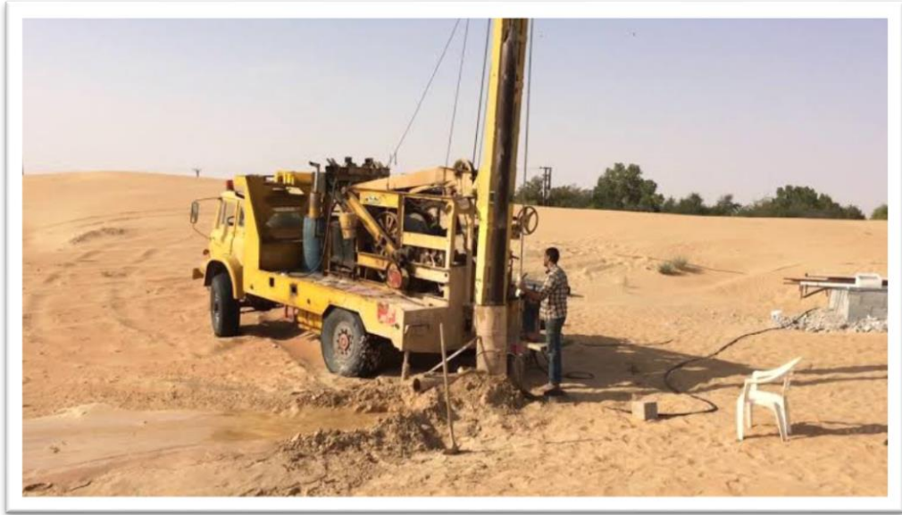
صورة (03): حفر بئر عميق
