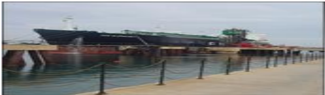
Figure 8 Quai de chargement de Navire du GPL1/Z
