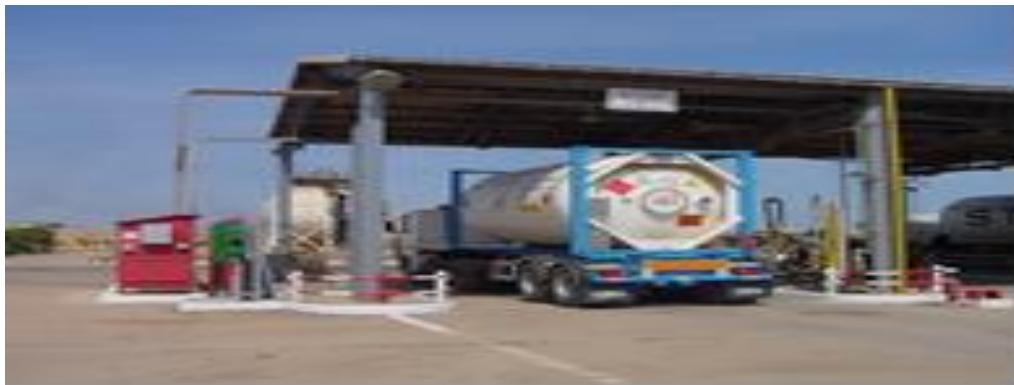
Figure 9 Rampe de chargement de camions du GPL1/Z
