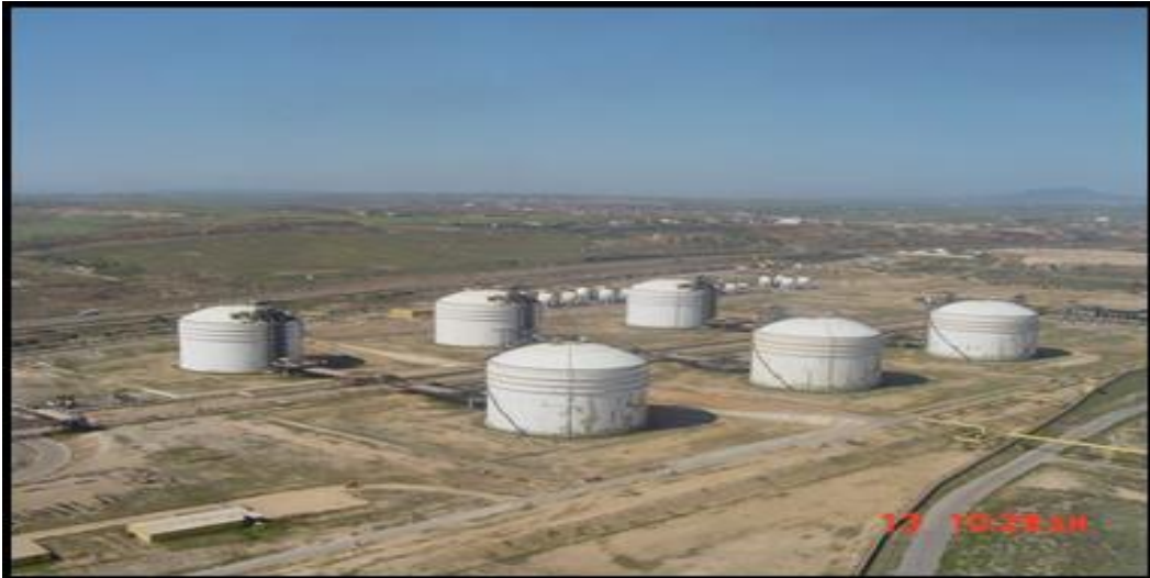
Figure 7 Les bacs de stockage des produits finis du GPL1/Z
