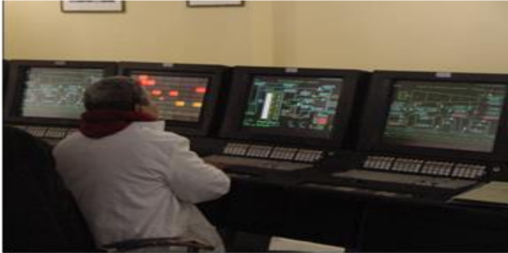
Figure 10 Système de télésurveillance du GPL1/Z
