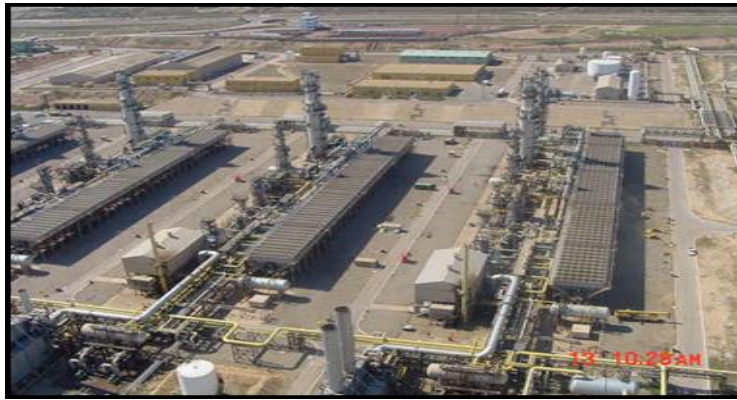
Figure 5 Les trains de traitement du GPL1/Z
