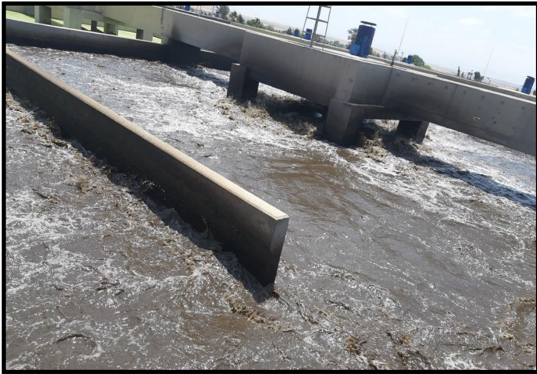
Figure II-11 Bassin d'aération
