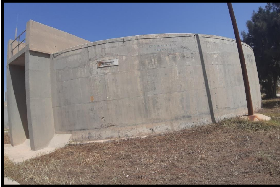
Figure II-14 Epaisseur primaire de la STEP.
