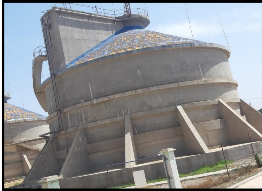
Figure II-18 Digesteur anaérobie
