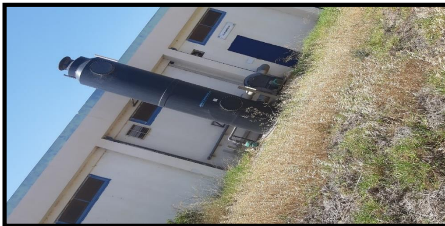
Figure III-5 appareil pour lavage du chlore
