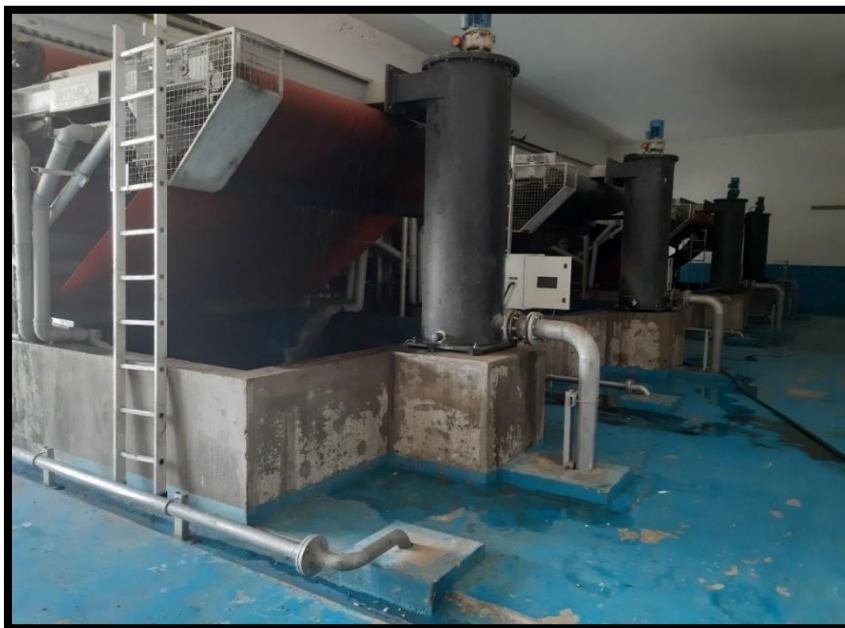
Figure II-21 tapie déshydratation mécanique des boues
