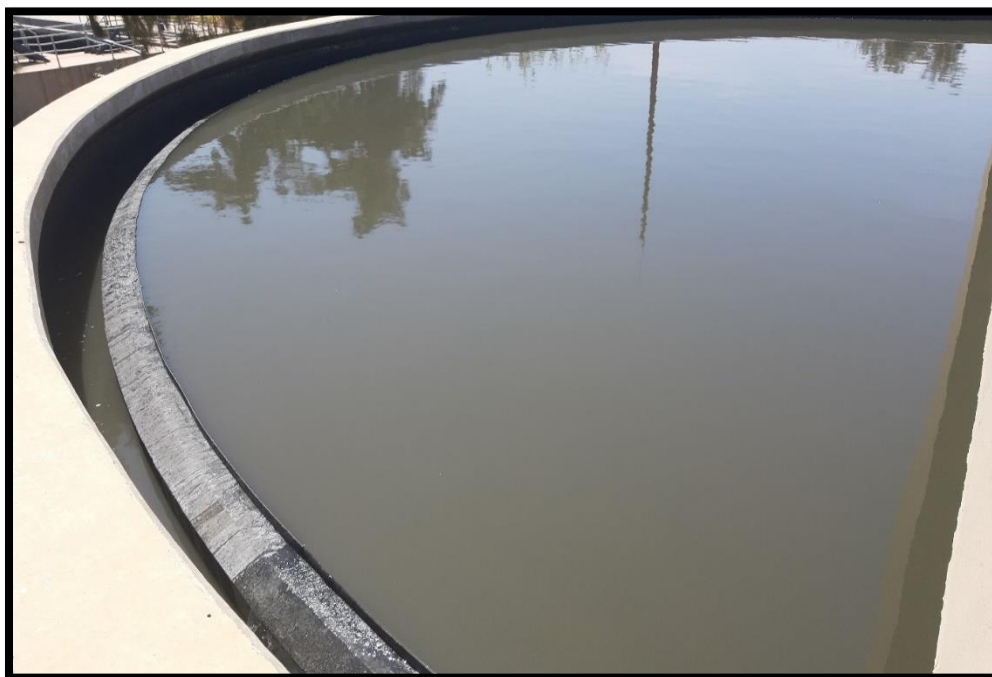
Figure II-17 Bassin d'homogénéisation
