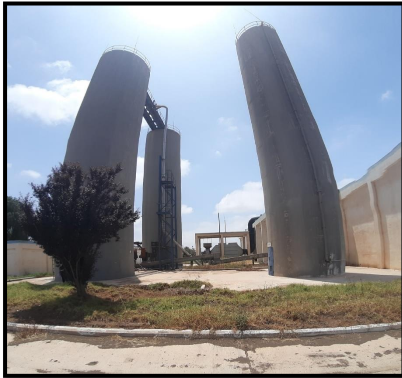
Figure II-23 Les silos de boues
