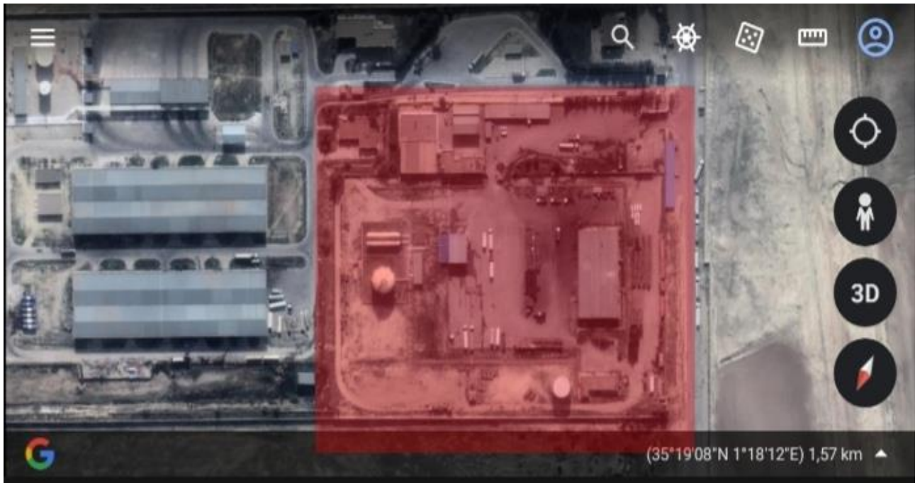
Figure V.3 : Vue par satellite du centre GPL-141- NAFTAL.
