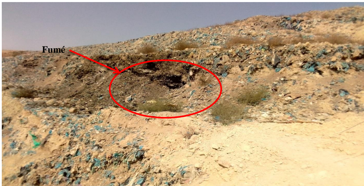
Figure III.22 : l'état du casier 1.
