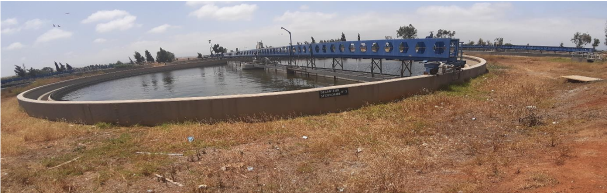
FIGURE III.7 DECANTEUR SECONDAIRE (2)
