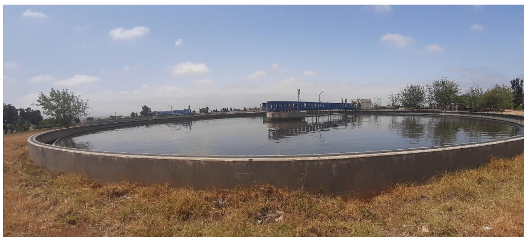
FIGURE III.5: UN DECANTEUR PRIMAIRE
