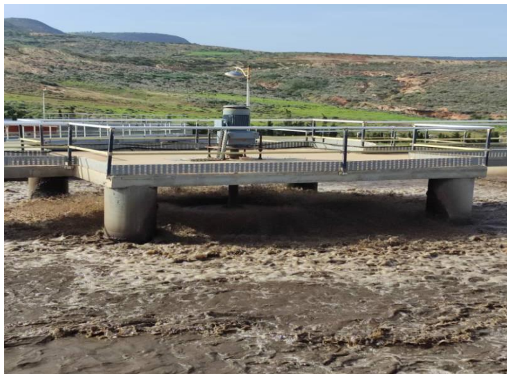
Figure 2. 9 : Bassin de contact en cours de travail.
