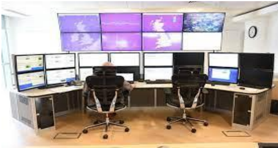
Figure 22 : salle de contrôle
