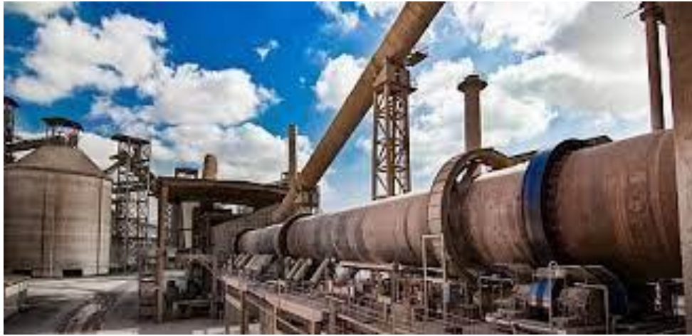
Figure 18 : Refroidisseur de LCO.
