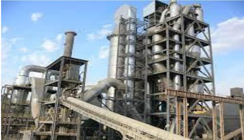
Figure 16 : Tour de préchauffage de LCO
