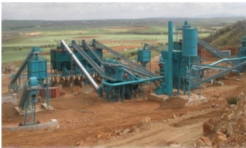
Photo.36 : Station de concassage de l'unité de l'ENG d'El Maleh.
