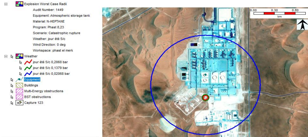
Figure 29 : les distances atteintes par l'explosion (Rupture).
