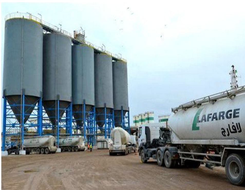
Figure (I.7) : Le stockage du clincker.
