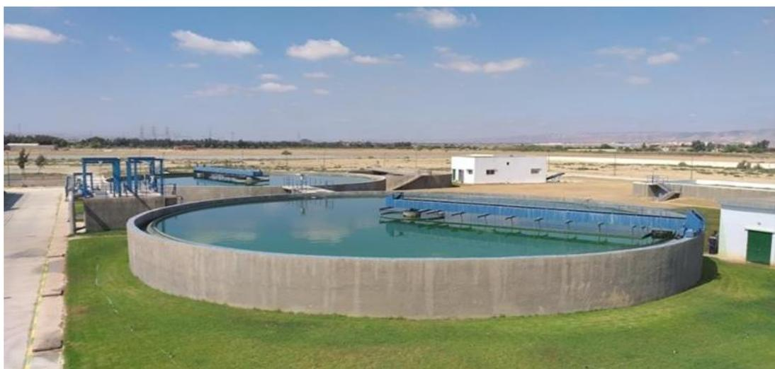
*Figure 31 - Clarificateur de la Station d'épuration de la Ville de Relizane*
