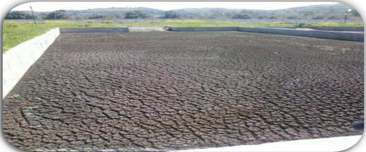
*Figure III.25 - Déshydratation des boues en lits de séchage*
