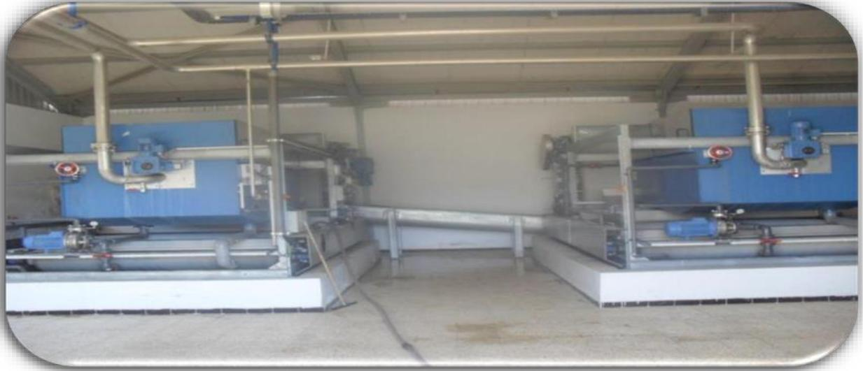
*Figure III.24 - Déshydratation mécanique des boues*
