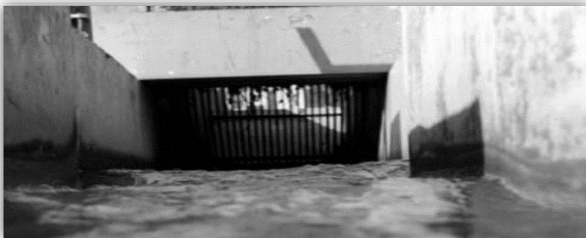
*Figure II.2 - Exemple d'un dégrilleur*
