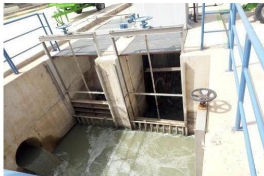
*Figure IV.28 - Dégrilleur de la STEP de la Ville de Relizane*
