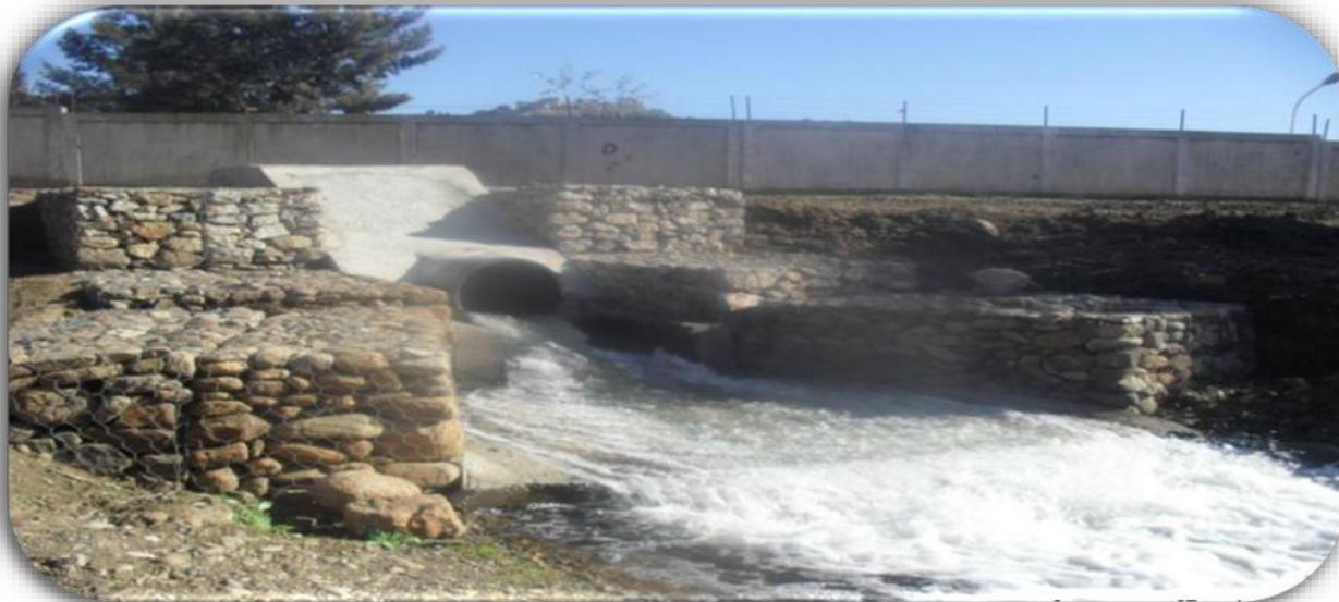
*Figure III.21 - La sortie des eaux épurées vers l'oued*
