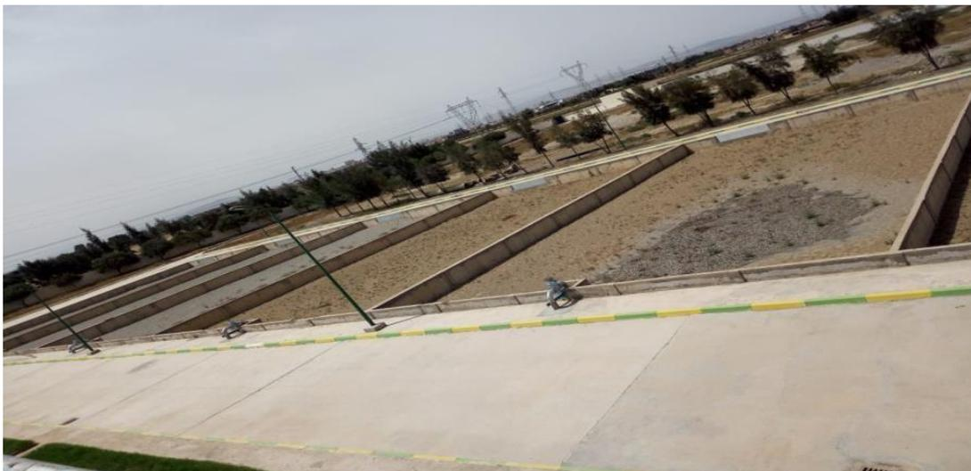
*Figure IV.32 - Lits de séchages de la Station d'épuration de la Ville de Relizane*
