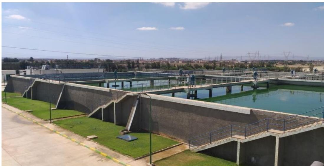
*Figure IV.30 - Bassin d'aération de la Station d'épuration de la Ville de Relizane*
