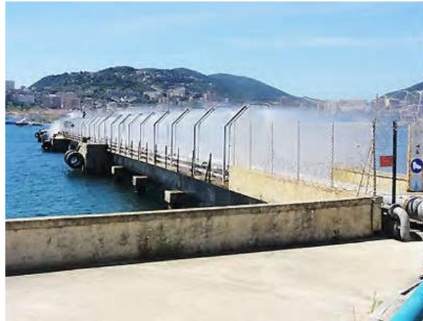
**Figure 48** Dispositif de pulvérisation sur quai
