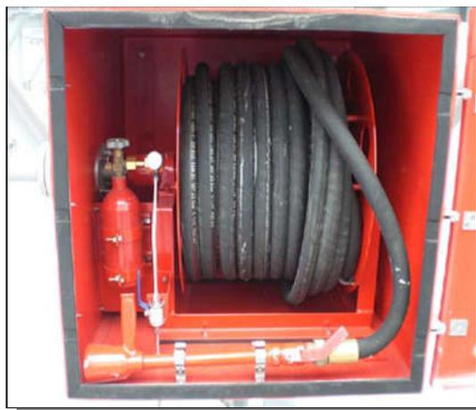
**Figure 70** *Système de tuyau à mousse manuel*
