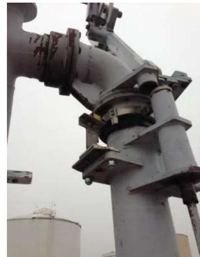
**Figure 23 Contacteur sur un bras de chargement**
