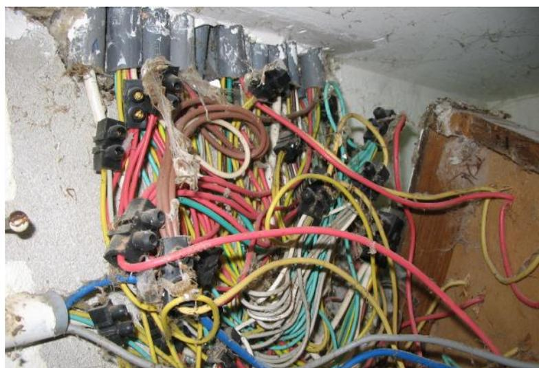
*Figure II.3* : Les installations en mauvais état
