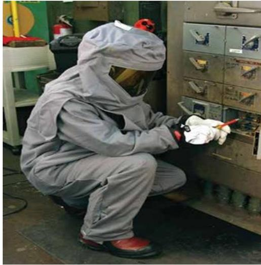
*Figure III. 2 : Equipement de protection ayant une cote anti –arc*
