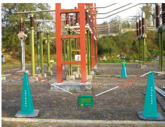
Figure II.71. Zone de travail signalisée
