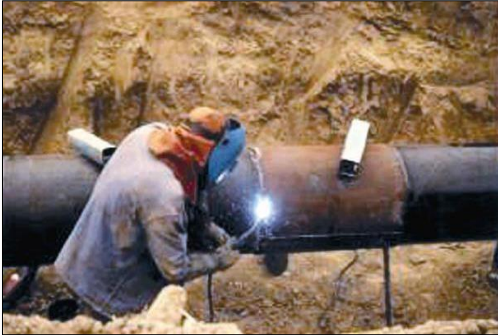
Figure 31 : Opération de soudages de demi coquilles (STT).
