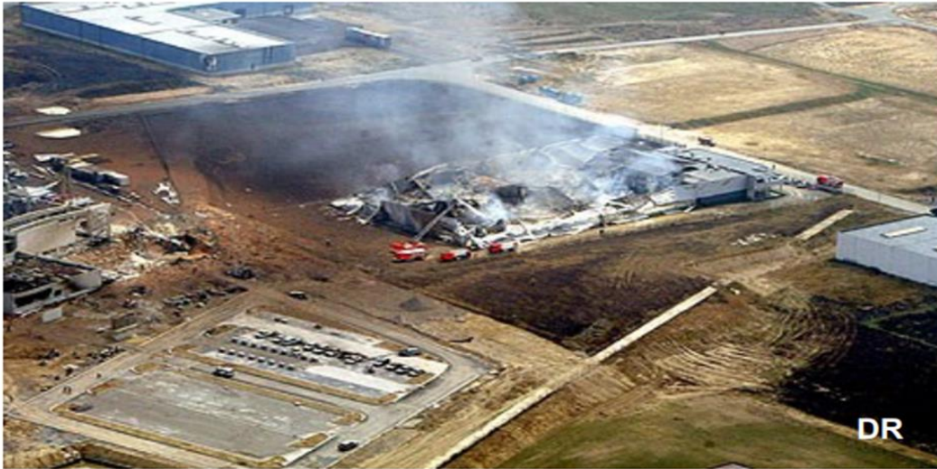
Figure 15 : Rupture et inflammation de BELGIQUE – GHISLENGHIEN
