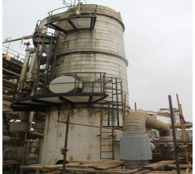
*Figure III-16 : Ballon den détente du propane 06*
