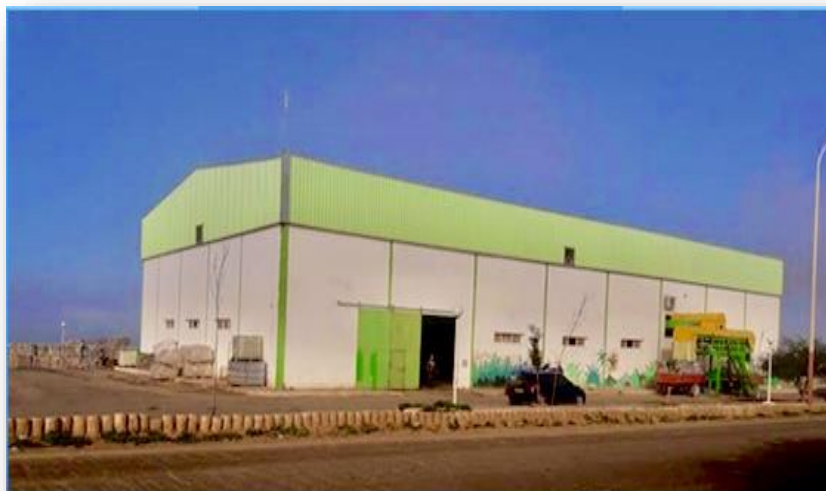
Figure III.11 : Un hangar de trie 600 m 2
