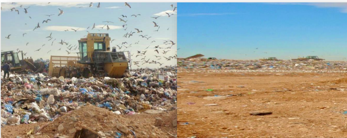
Figure IV.7 : Casier au cours de compactage et de la couverture
