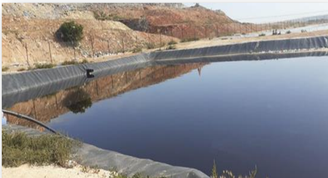
Figure II.12 : Bassin collecteur des lixiviats bruts.
