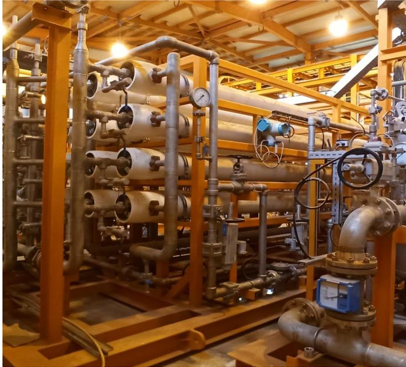
**Figure II.4 :** L'osmoseur inverse de la station de traitement des eaux, Nâama
