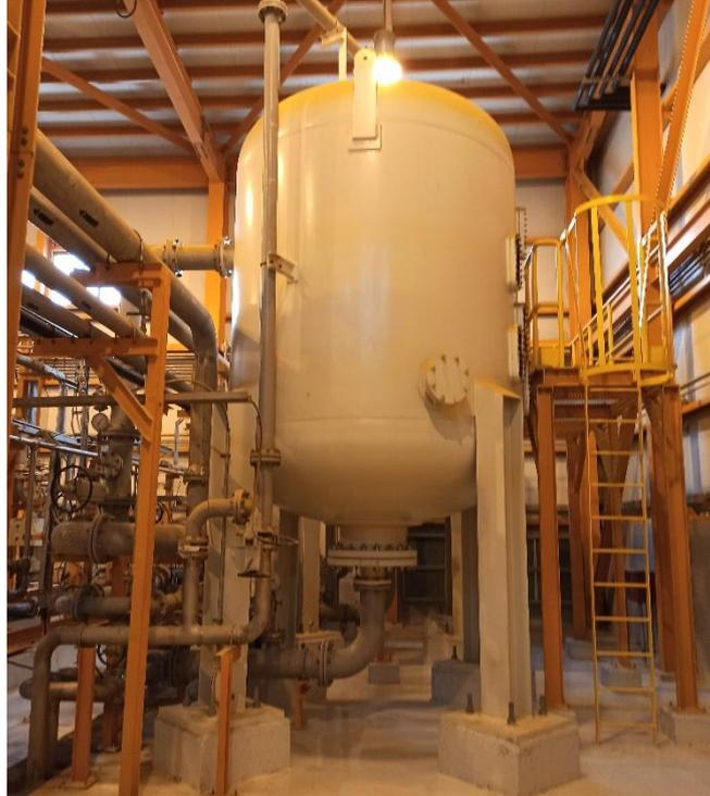
**Figure II.3 :** Désableur des eaux brutes de la station de traitement des eaux, Nâama
