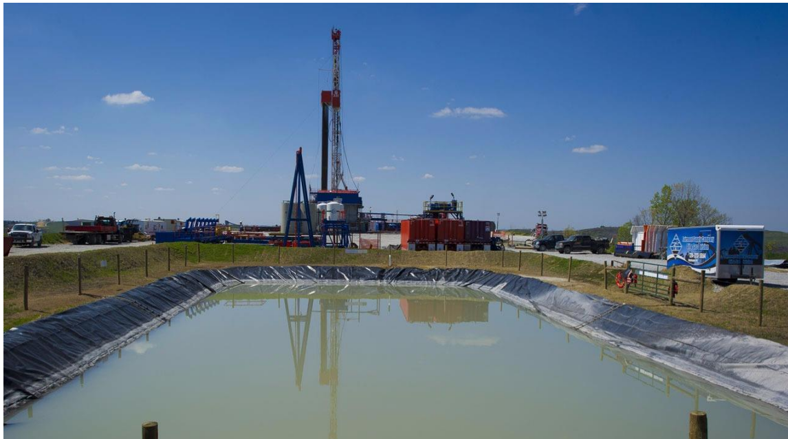
Figure 3.4. Exemple d'un bassin qui contient les eaux usées de la fracturation hydraulique [157]
