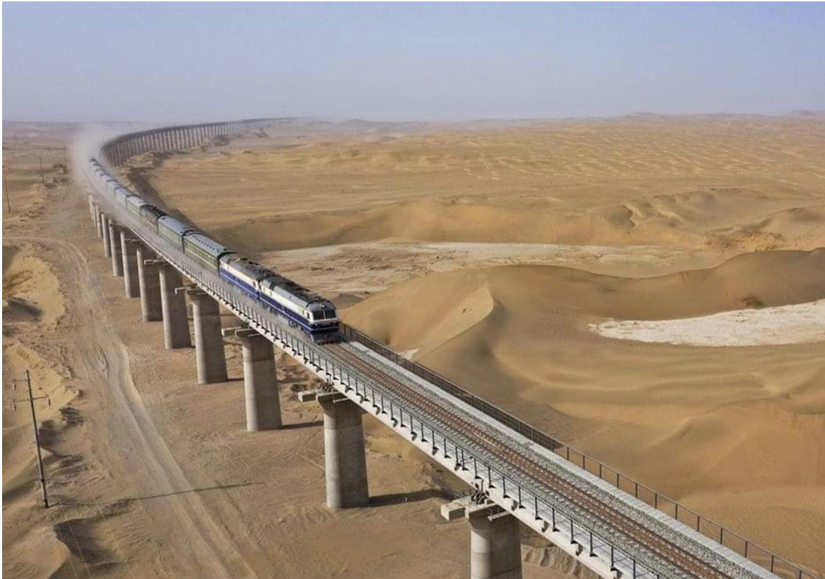
Chine : lutte contre le phénomène d'ensablement par le moyen d'un pont suspendu
