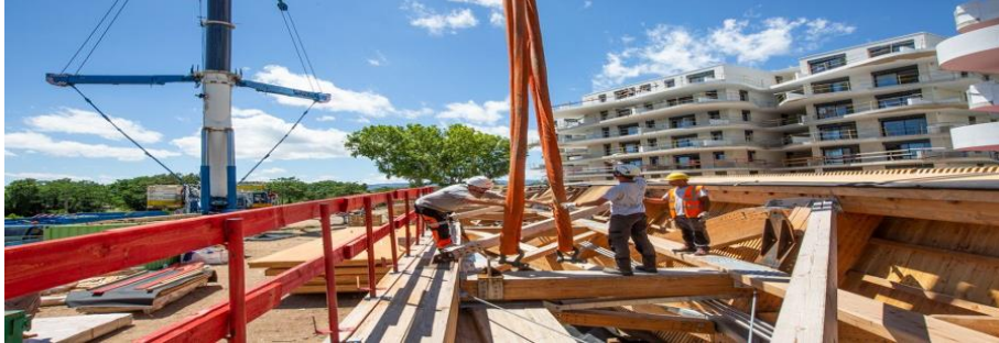
Figure 2.8: Outils posés aux bords des passerelles
