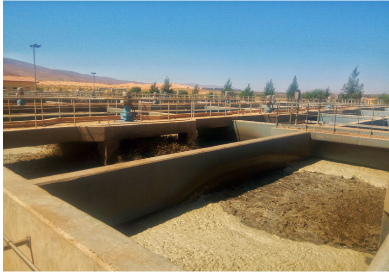
Figure III.5. Le bassin d'aération siège du traitement.
