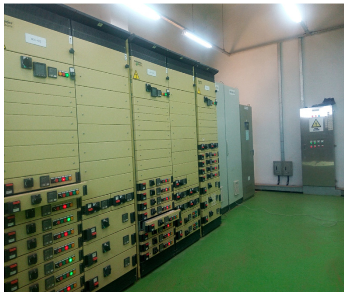
Figure III.18. Photo du MCC station d'épuration ONA d'Ain Sefra.
