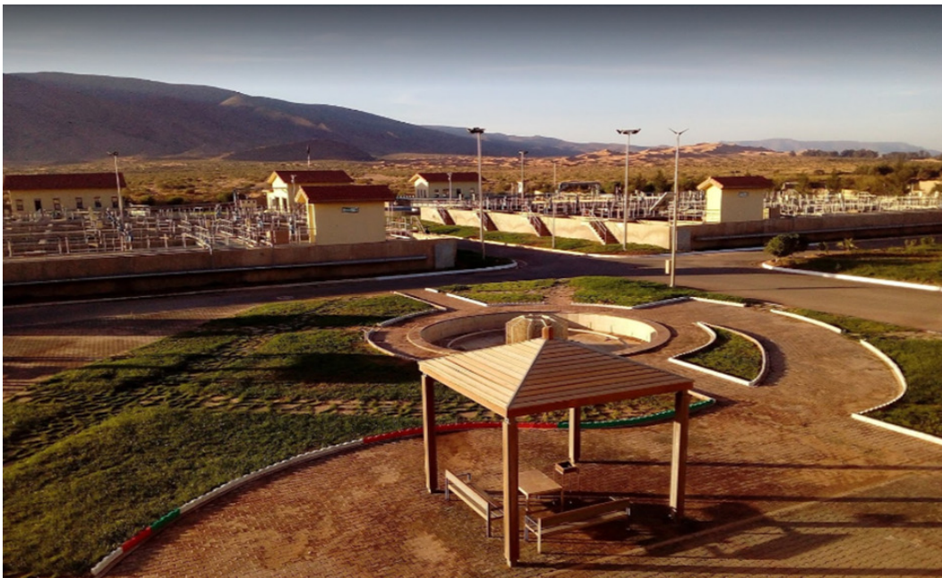
Figure III.1. Station d'épuration d'Ain Sefra.
