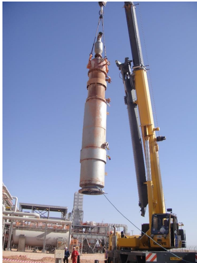
Figure III-3 : Opération de levage.
