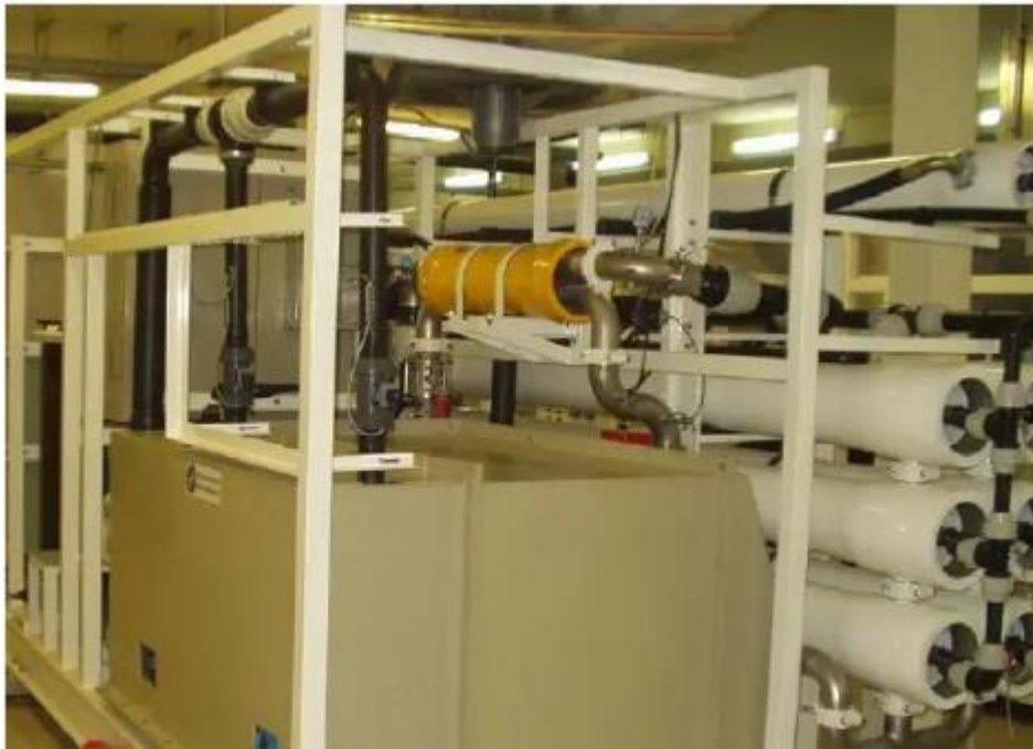
Figure II.9. : Echangeur type PX 180 sur l'une des unités SLCE de 500 m 3 /jour.
