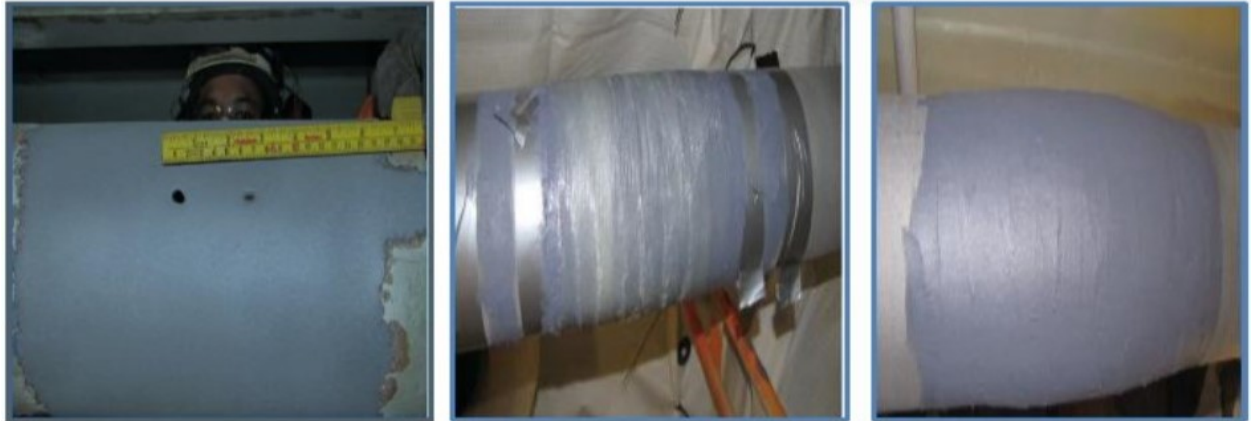
Figure (II -15): Réparation par composites d'un pipe en acier
