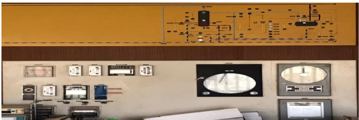
Figure IV.16. Tableau d'affichage de paramètres des unités en dessous des enregistreurs graphiques et des régulateurs utilisés pour fixer des consignes d'entrées
