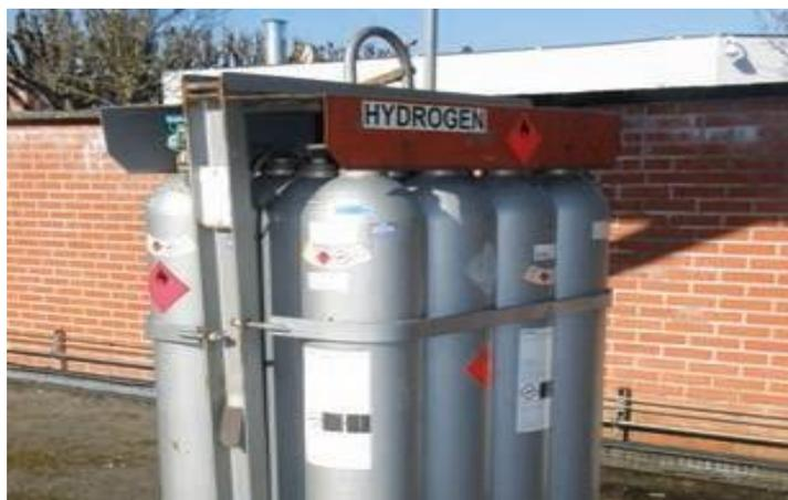
Figure III.20 : Exemple de cadres de neuf bouteilles
