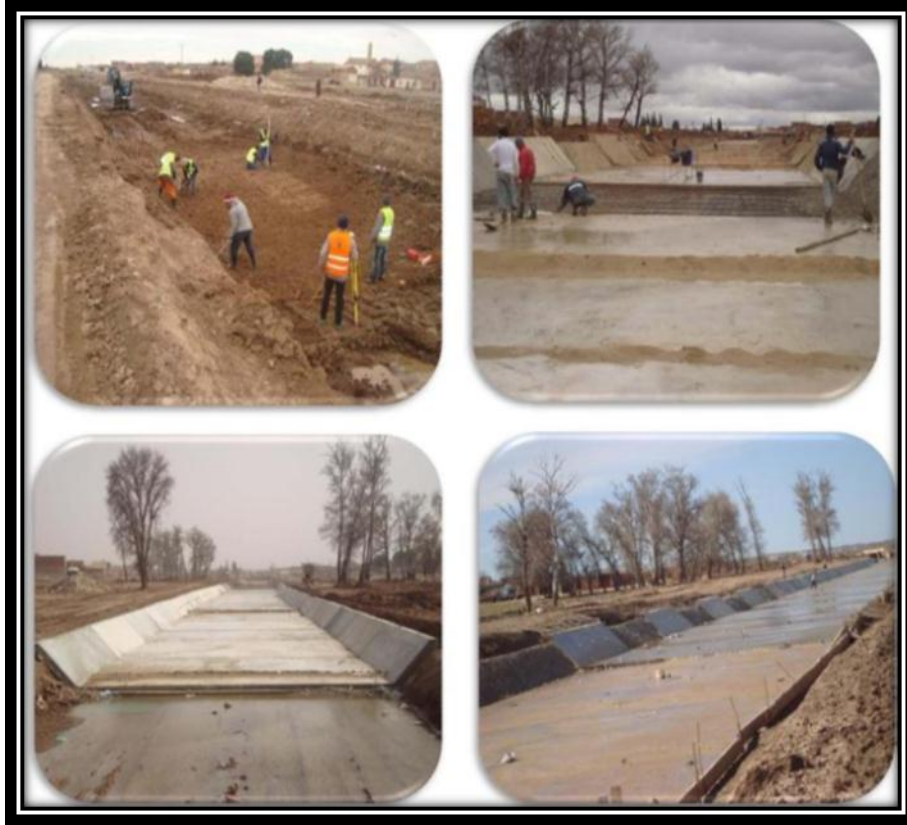
الصورة08: تحقيق قناة شبه منحرفة
