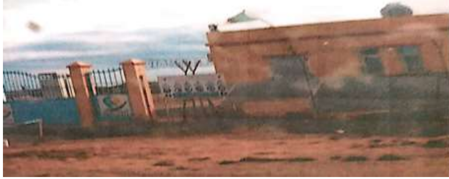
الصورة رقم 05 مركز الحراسة
