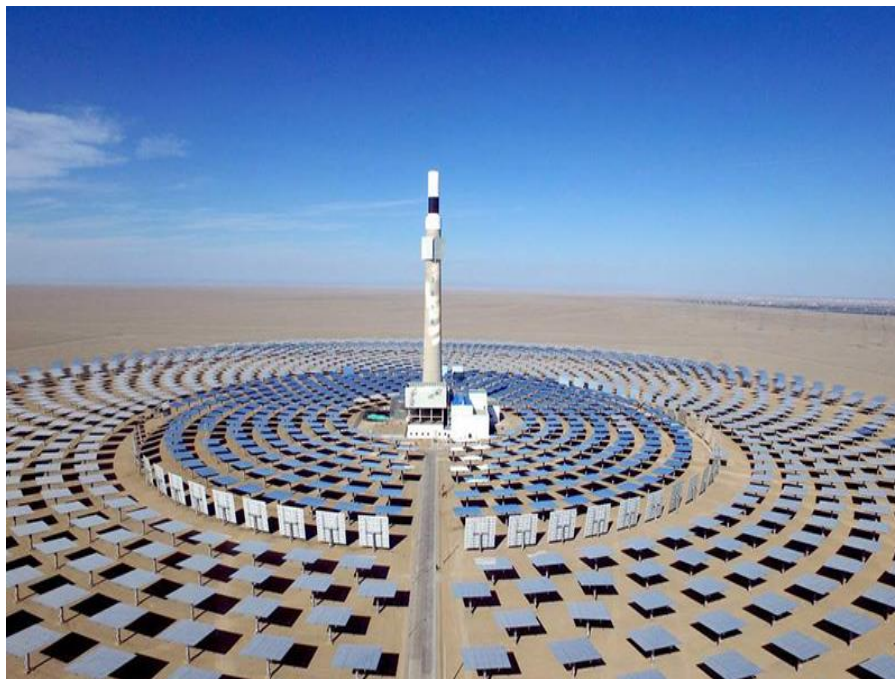
Figure.II.7. Centrale à tour solaire
