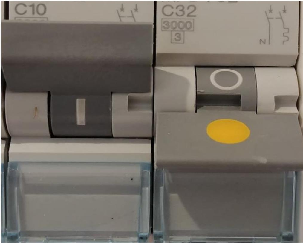
**Figure 2 :** Position 1 – ON à gauche, Position 0 – OFF à droite
