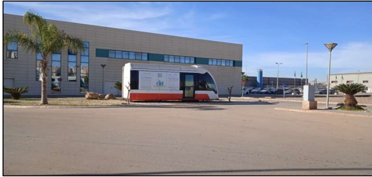
Figure I.3 - Unité Opérationnel Tramway (SETRAM ORAN)
