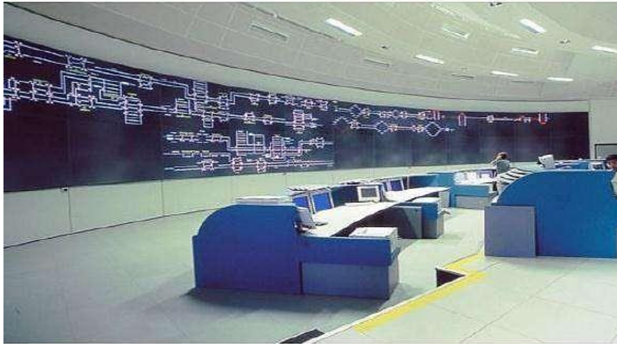
Figure III.2 - Système de contrôle et d'acquisition de données
