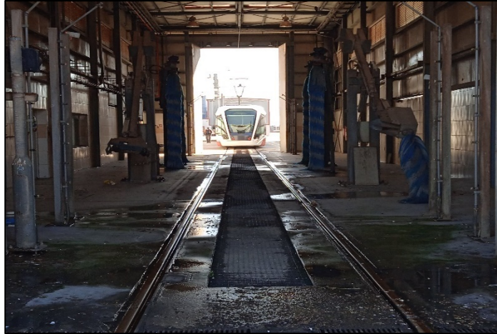
Figure I.8.2. - Poste de lavage
