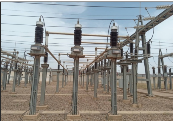
Figure II.1.2.3 - Jeux de barres
