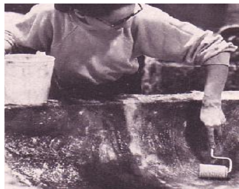
Figure I.10: Procédé de moulage par contact
