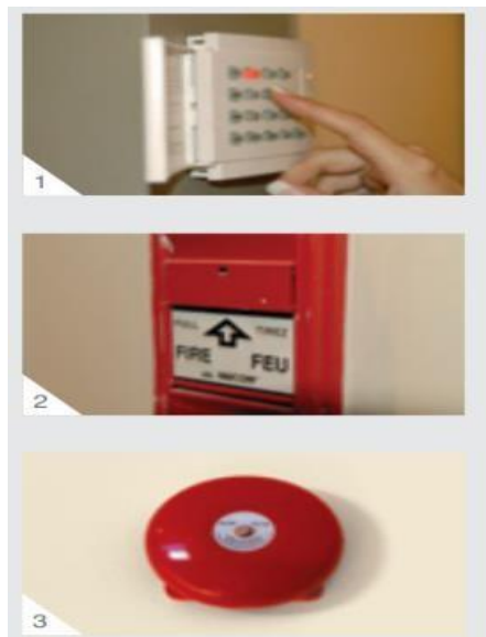
Figure II. 6 : Système d'alarme incendie
